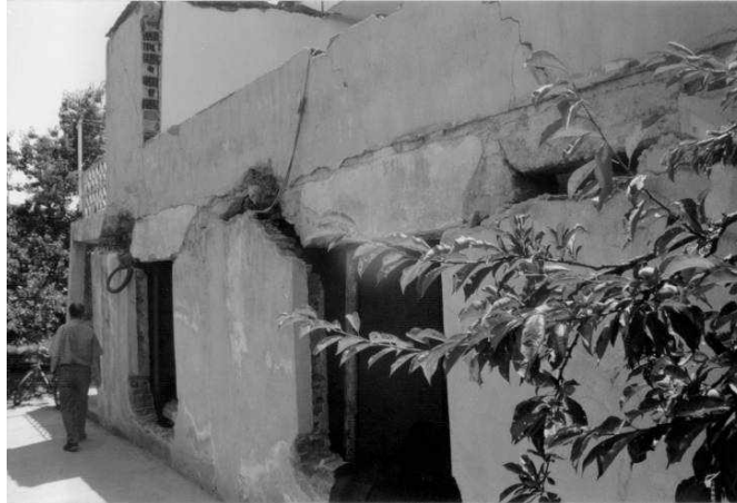
Şekil 4. Sarıgöl Fayı'nın düşen bloğu üzerinde yer alan ağır hasarlı beton bir binanın görünümü.
