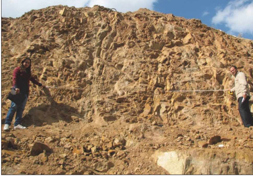
Şekil 2. 2 Numaralı alandaki kaya şevinde yapılan hat etüdü çalışması.
