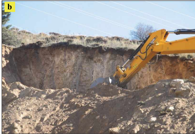
Şekil 8. (a) 1 numaralı alandaki orta derecede, ve (b) 4 numaralı alandaki ileri derecede ayrışmış kaya kütlelerinde yapılan kazı çalışmaları.
