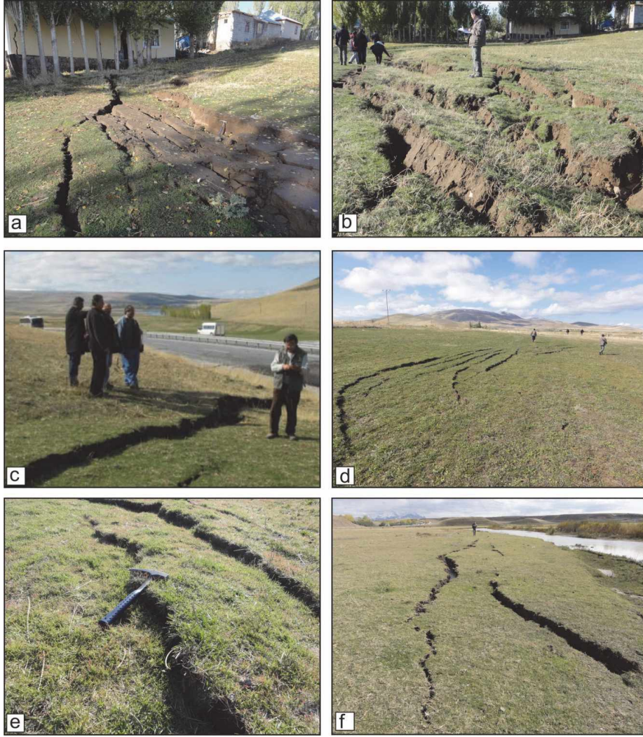
Şekil 7. (a, b) Çelebibağ Mevkii kuzeyinde gelişen heyelan/yanal yayılmayı gösteren arazi fotoğrafları. Çatlaklar arasında kalan blokların çatlak yüzeylerine ters yönde eğimlendiğine (geriye doğru çarpılma) dikkat ediniz, (c) Gedikbulak Köyü çevresinde gelişen yanal yayılmayı gösteren arazi fotoğrafı, (d) Göllü ve Alaköy çevresinde gelişen yanal yayılma yapılarına ait arazi fotoğrafları. Fotoğrafta gelişen dairesel çatlaklar yüzeye çıkamayan sıvılaştırma yapısının varlığına işaret eder, (e) Yanal yönde devamsız ters fay geometrisi sunan yüzey deformasyonları, (f) Topaktaş Köyü civarında gözlenen yanal yayılma yapıları
