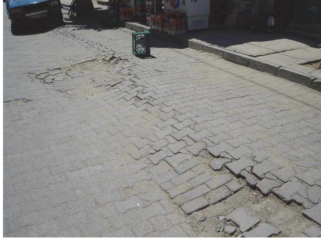
Şekil 3. Sarıgöl Fayı boyunca gözlenen yüzey deformasyonları.
